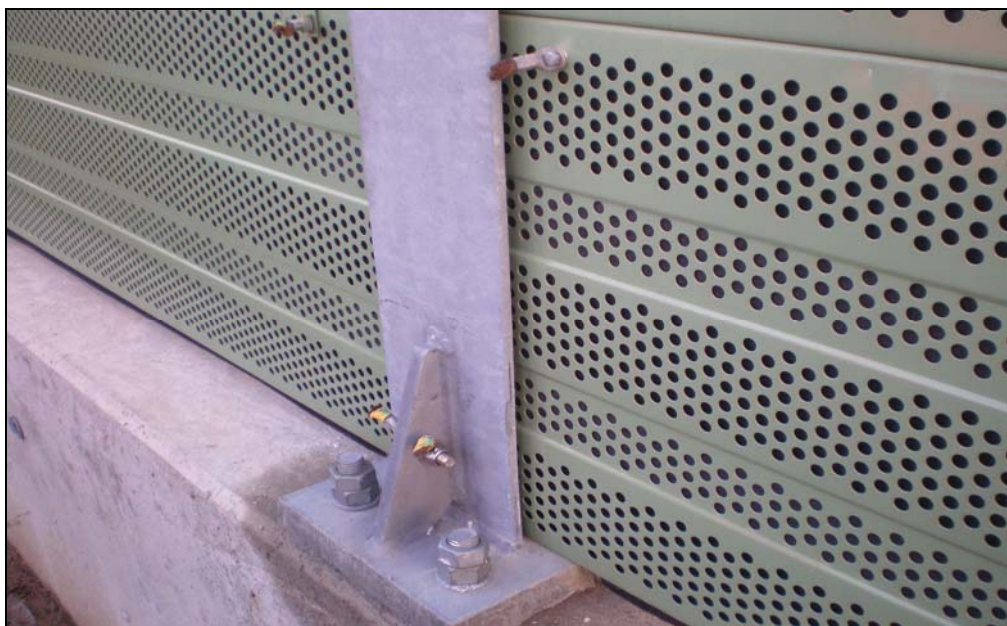
Снимка № 13: Близък план на шумозащитен екран в началото на Лот 2 след гара Първомай. Заземителните проводници вече липсват
