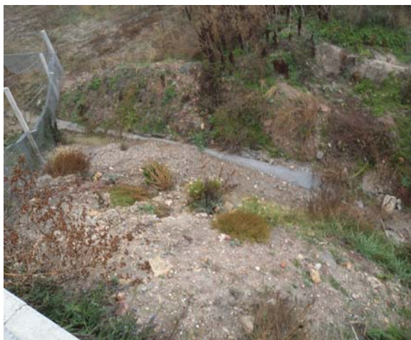
Затлачена и запълнена с материали от откоса канавка ЛОТ 2 на АМ „Тракия” Снимка № 31
