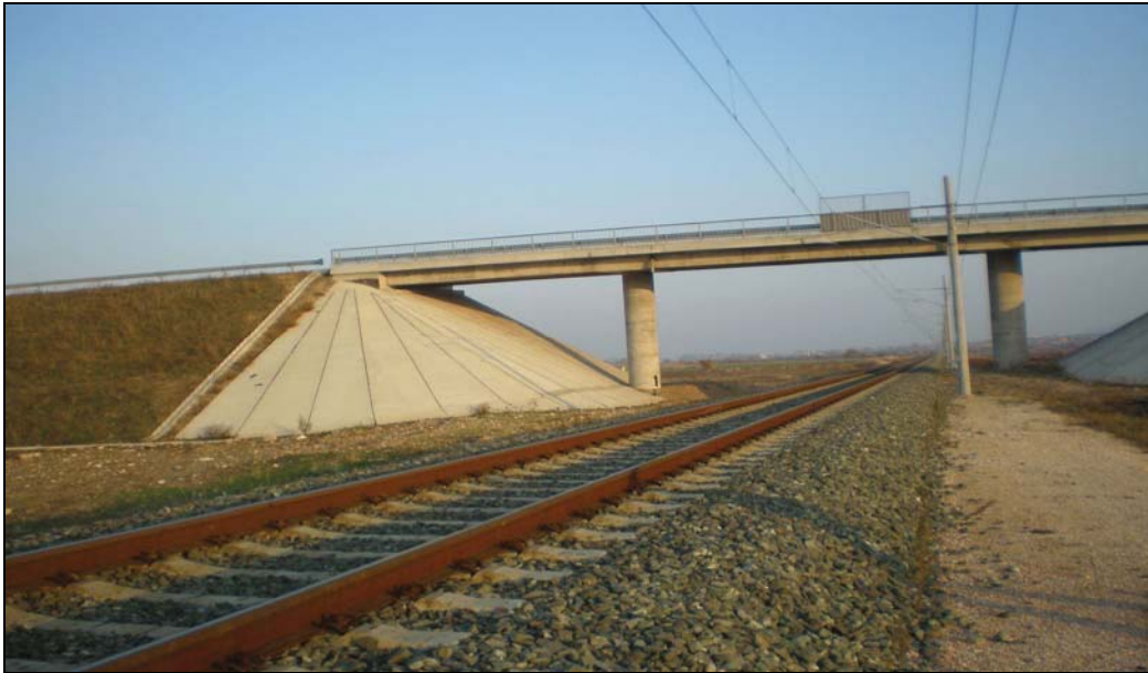
Снимка № 9: Общ вид при Лот 2, км 209+800 в посока Свиленград. Вижда се новоизграден надлез като е оставено място за бъдещо удвояване на жп линията
