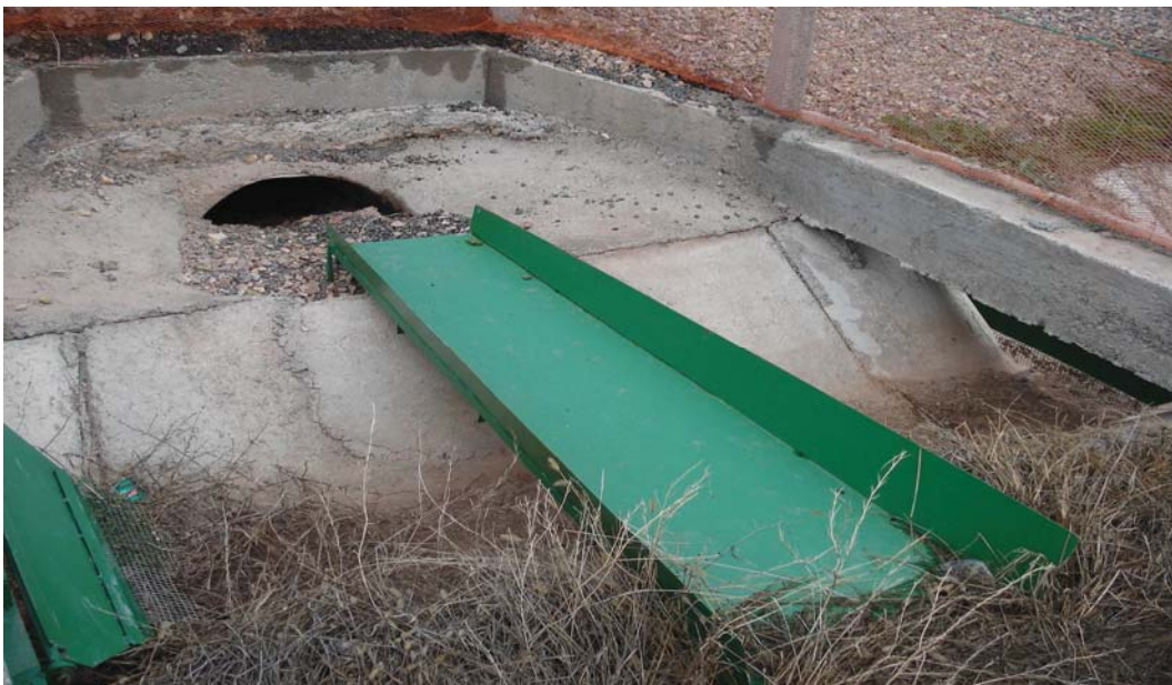
Снимка № 26: Излят бетон от бетоновозите
