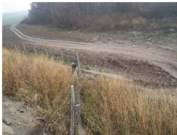
Канавка, завърриваща в равна част на терена (преди надлез), която няма къде да отведе водата – ЛОТ 2 на АМ „Тракия” Снимка № 34
