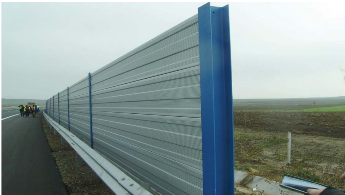
Снимка № 30: Звукопоглъщащ шумозащитен екран
