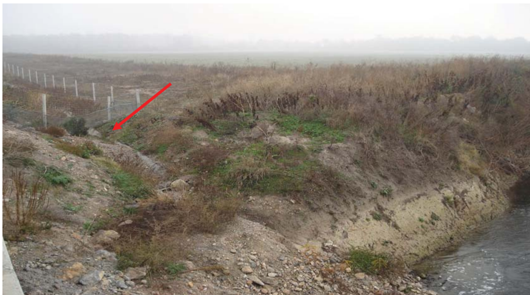
Снимка № 19: Заграждение със ситна мрежа в основата
