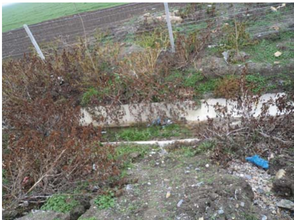
Затлачена канавка и следи от браздова ерозия по Лот 2 на АМ „Тракия” Снимка № 33
