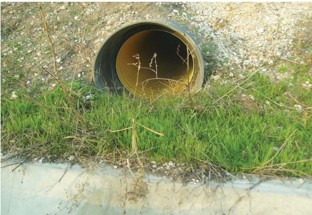
Снимка № 2: Проход за дребни животни под жсп линията при Лот 2, км 210+000 без покритие над канавката
