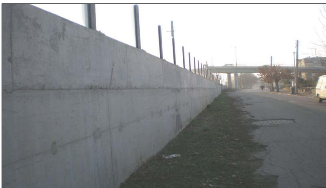
Снимка № 8: Шумозащитен екран в края на Лот 1 при гара Първомай. На заден план се вижда новоизграден надлез над жп линията
