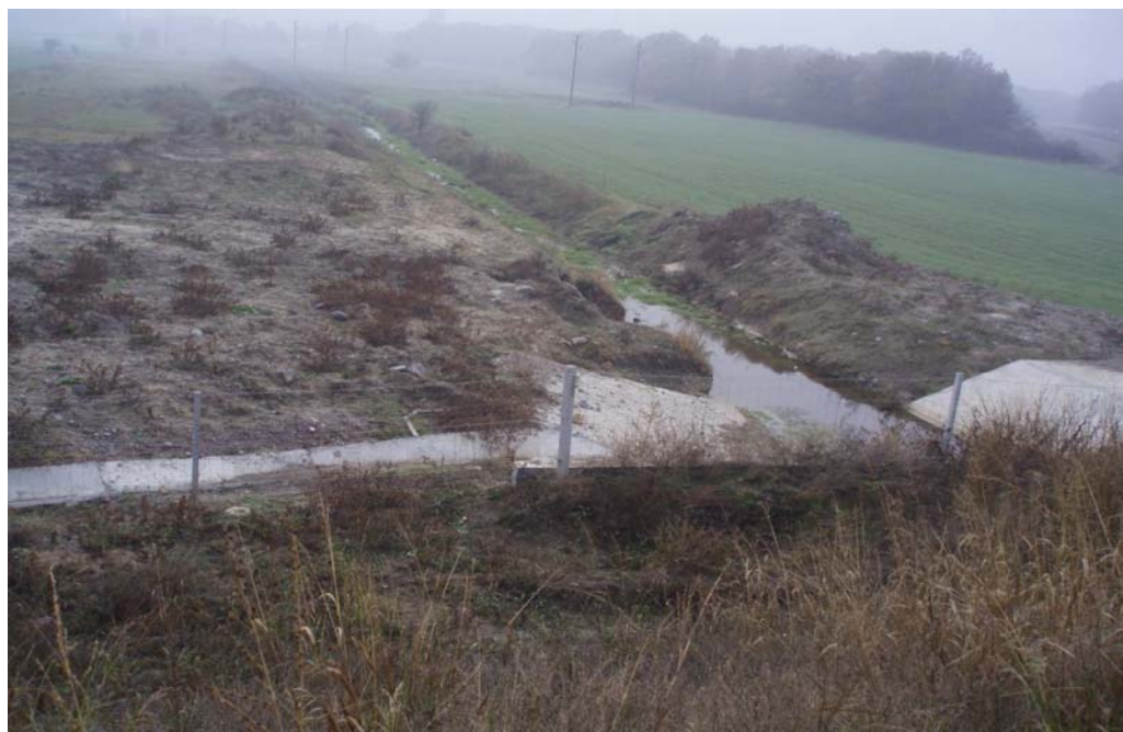
Снимка № 37: Крайпътен окоп завършващ в равен терен
