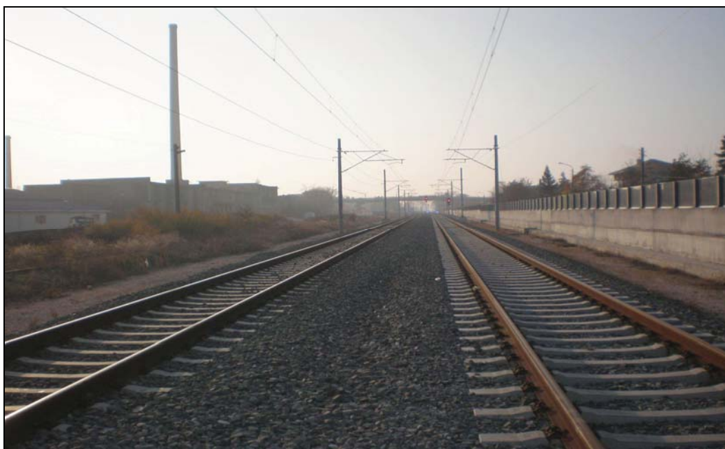
Снимка № 7: Общ вид на жп линията в края на Лот 1 при гара Първомай. Използва се само левия коловоз. Десният ще се ползва след планираното в бъдеще удвояване на жп линията. Вдясно се вижда новоизграден шумозащитен екран
