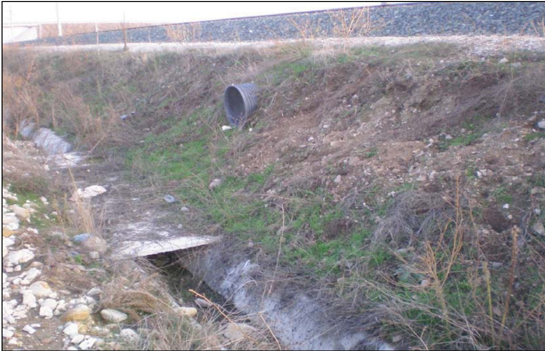
Снимка № 1: Проход за дребни животни под жсп линията при Лот 2, км 209+750 със запазено покритие над канавката
