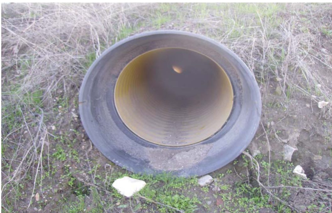
Снимка № 4: Липсва положен слой от пясък или пръст
