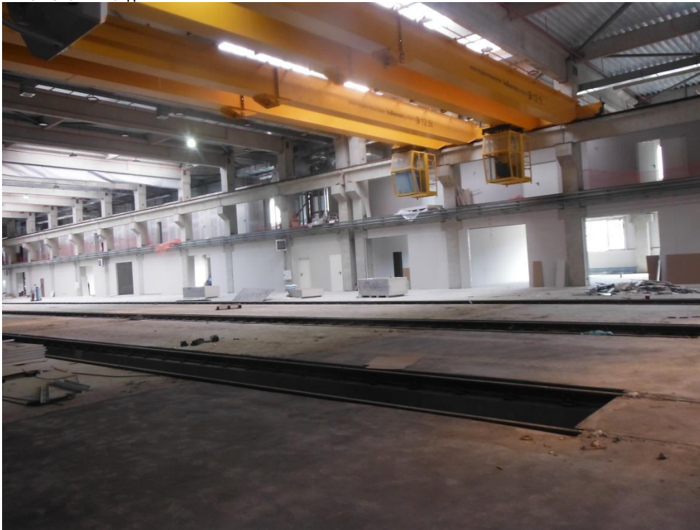
Снимка 15 Ремонтно помещение
