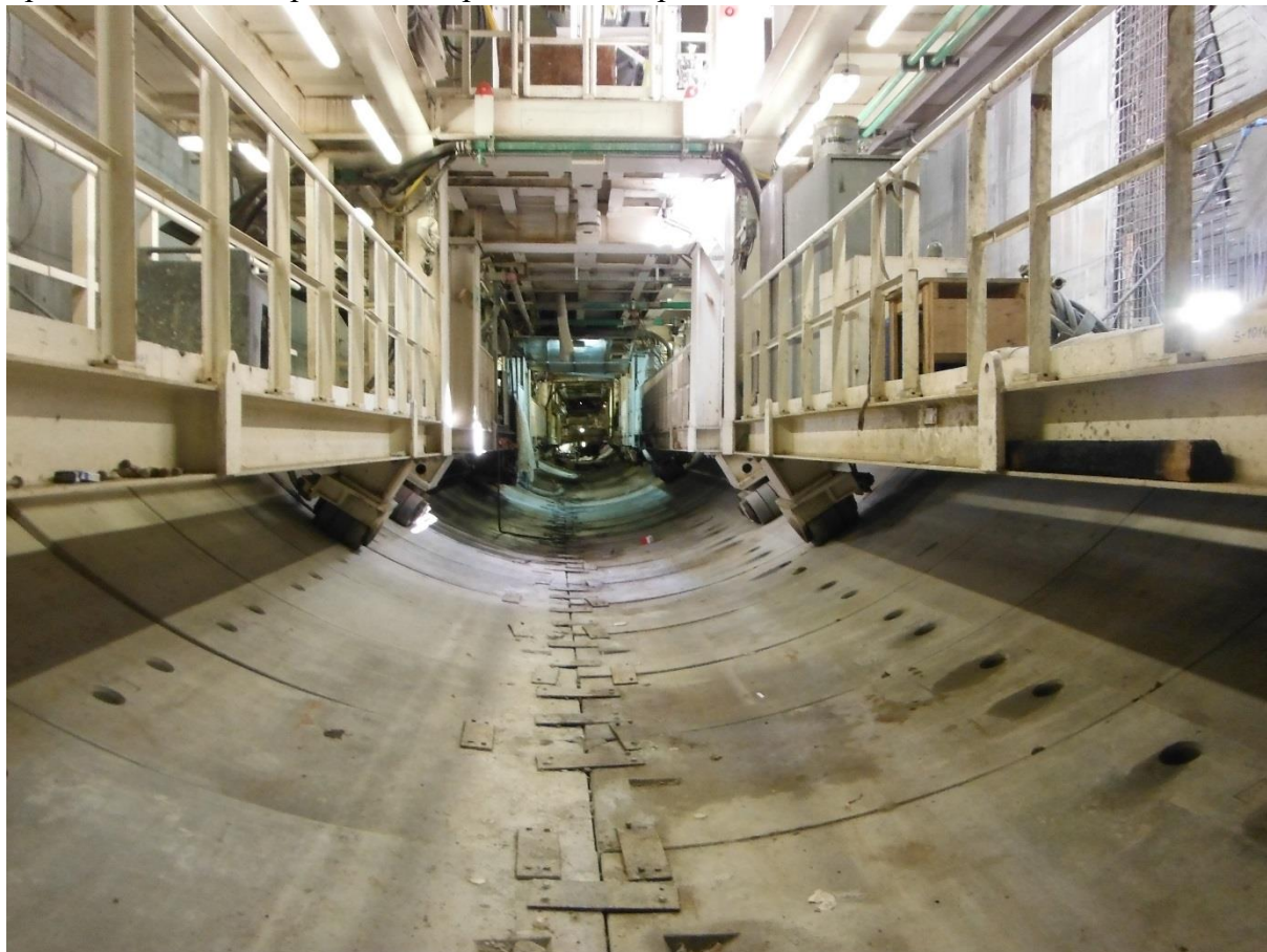
Снимка 11 Тунелопробивната машина, строяща трети метродиаметър
