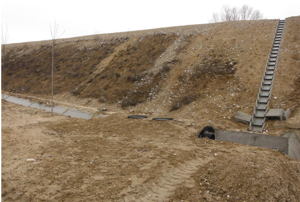
Снимка 19. Отводнителни канавки и каломаслоуловител
