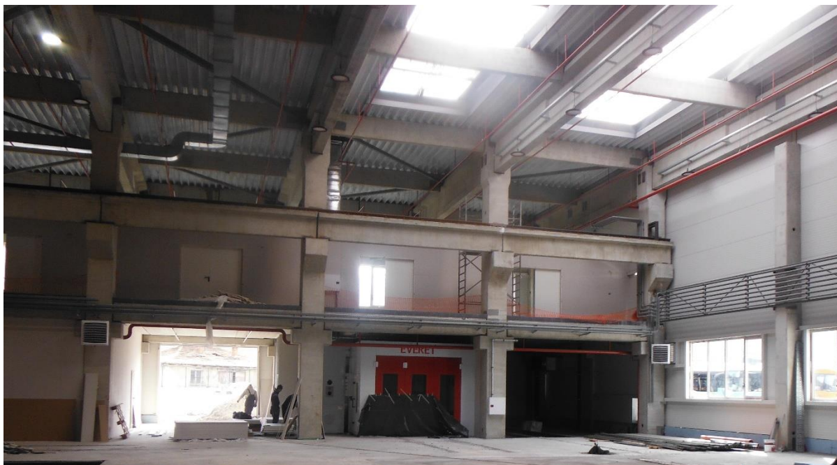
Снимка 18. Ремонтен цех в депо „Земляне“
