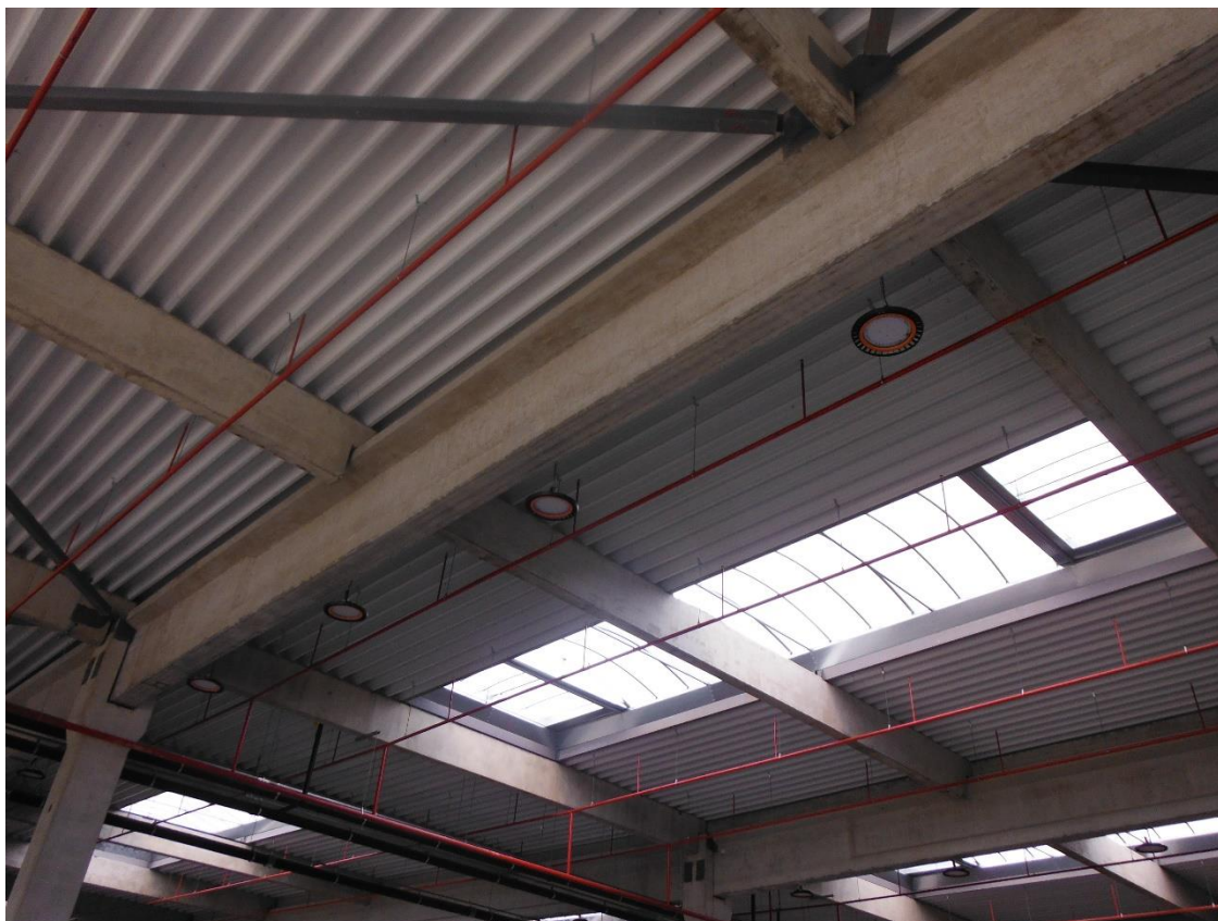
Снимка 20. Противопожарна инсталация в депо „Земляне“
