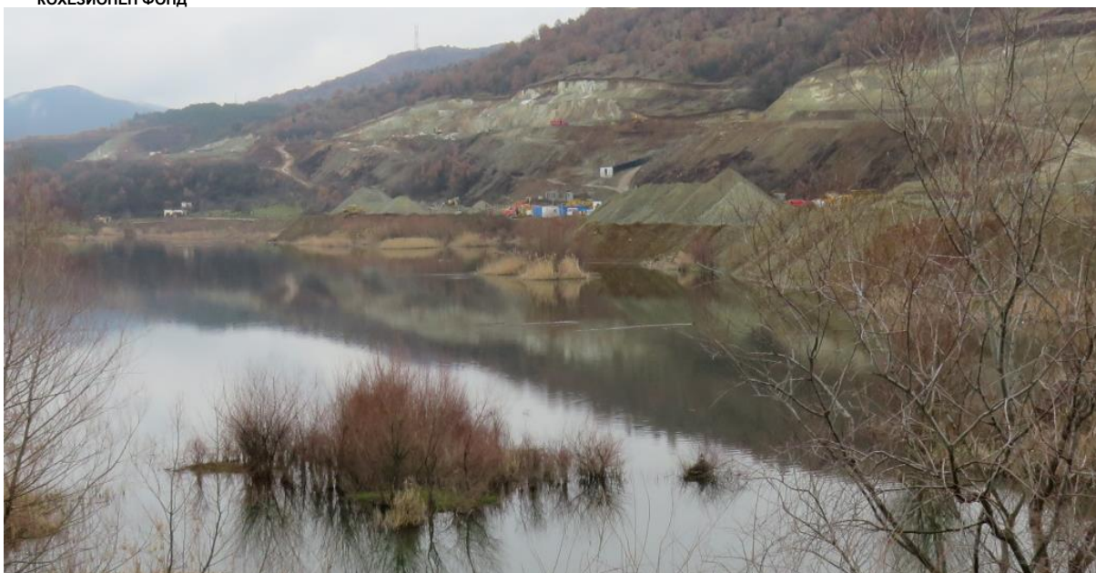
Снимка 27. Насипване на земни маси и инертни материали във водното огледало в местн. Бистрака.
