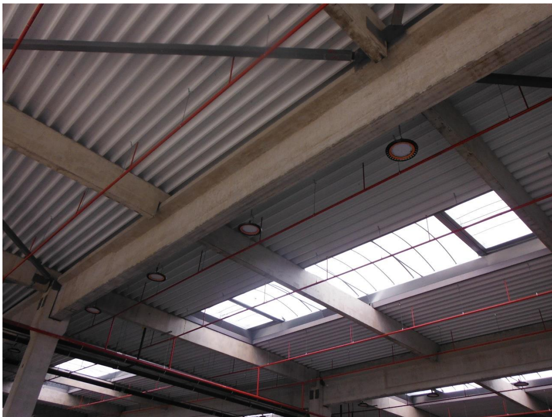
Снимка 20. Противопожарна инсталация в депо „Земляне“
