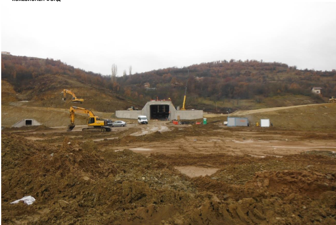
Снимка 1: Строителна площадка на АМ Струма, Лот 3.1.
