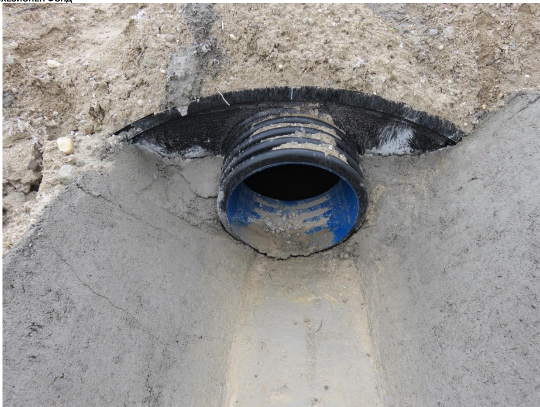
Снимка 29. Небезопасен вход на маслоуловител
