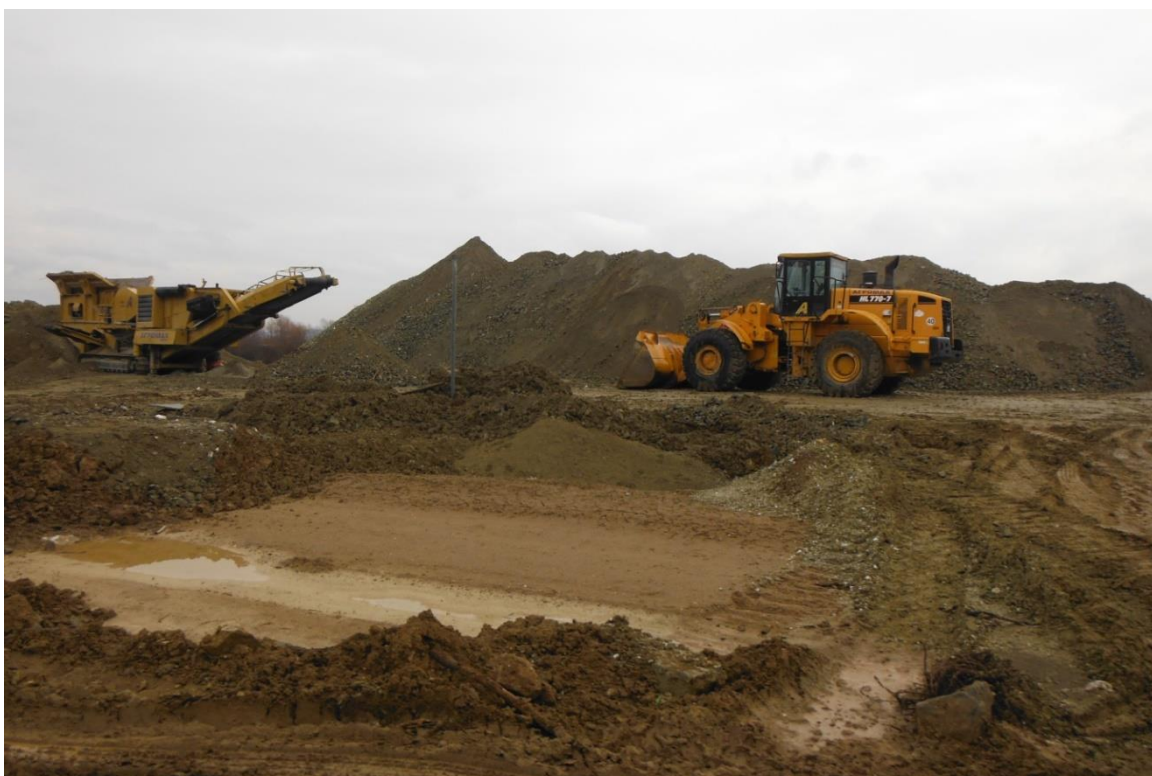
Снимка 2: Строителна площадка на АМ Струма, Лот 3.1.
