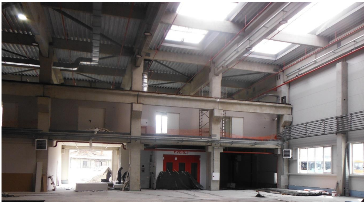
Снимка 18. Ремонтен цех в депо „Земляне“
