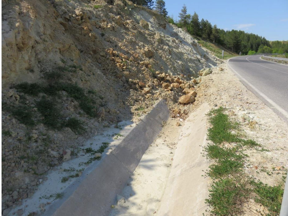
Снимка 22 Свличане на земни маси
