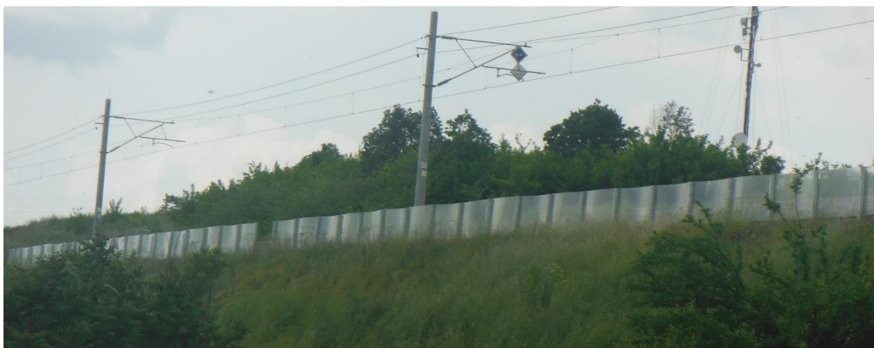
Снимка 53 Шумозащитен плексигласов екран в с. Бисер. Вижда се липсващ елемент, който компрометира ефективността на съоръжението
