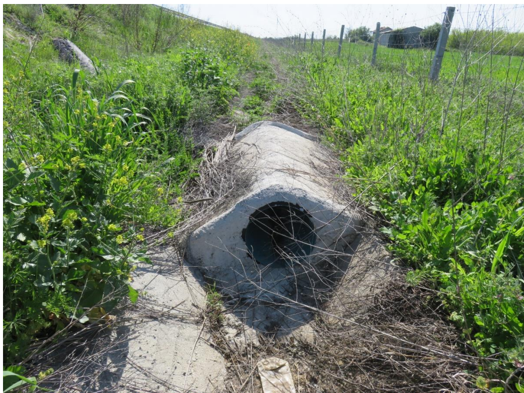
Снимка 37 Премостване на канавки.
