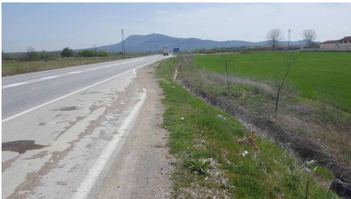
Снимка 13. Непочистени отводнителни канавки
