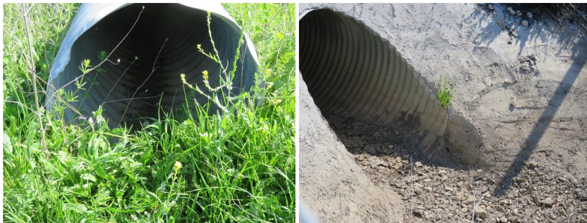
Снимка 36 Незапръстен и запръстен проход
