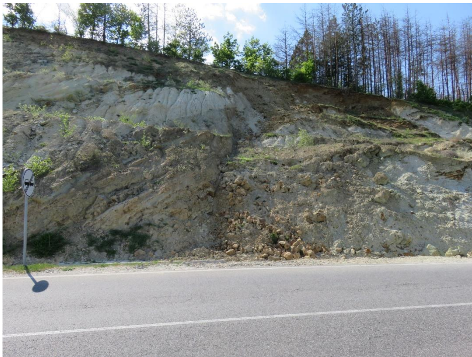
Снимка 21. Свличане на земни маси
