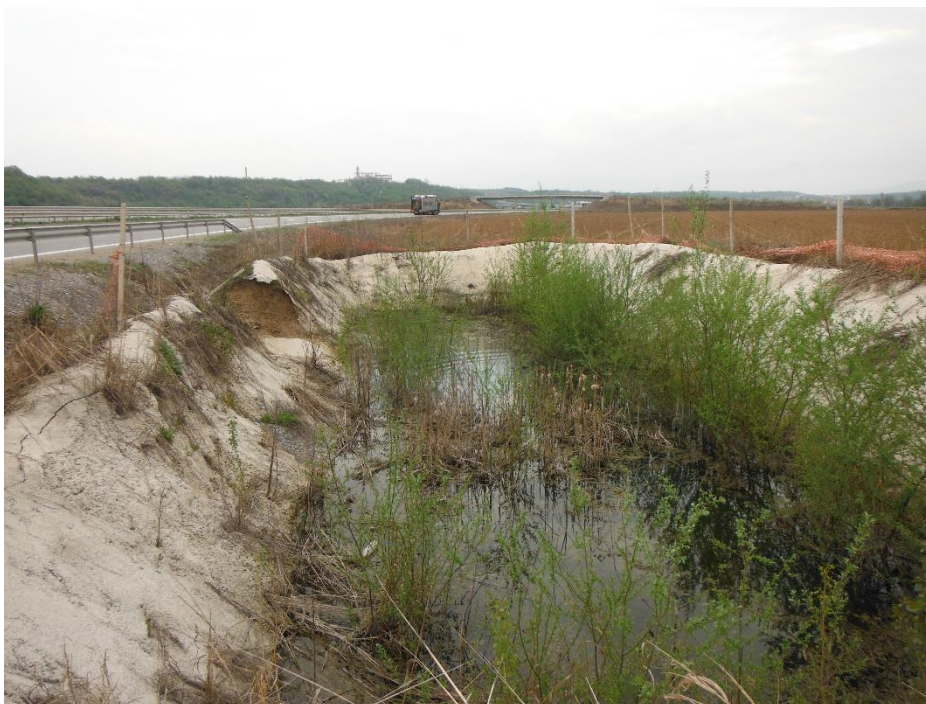
Снимка 16. Изпарител в недобро техническо състояние
