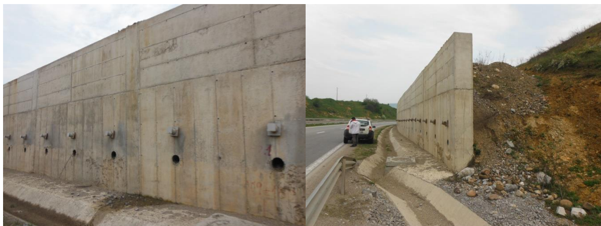
Снимка 1 Укрепителни съоръжения
