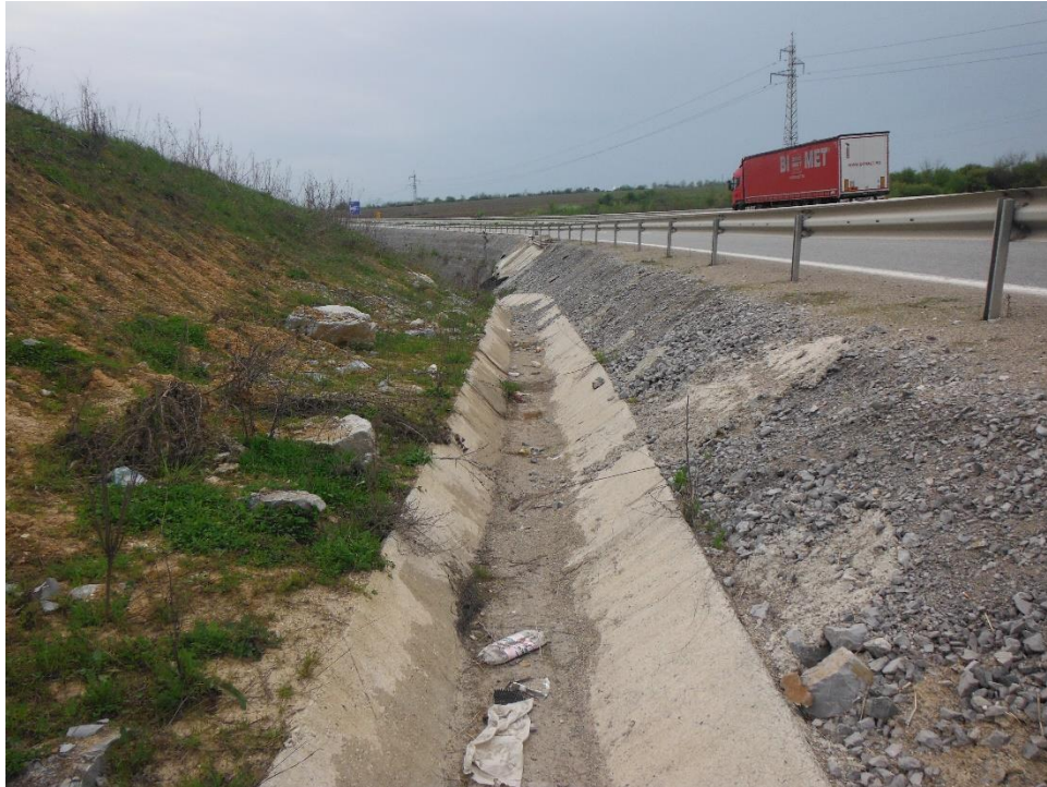
Снимка 14. Непочистени отводнителни канавки
