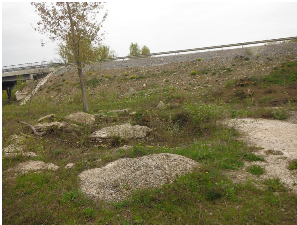
Снимка 24. Непочистени строителни отпадъци
