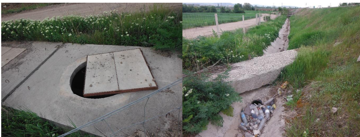
Снимка 43 Преместени капаци и непочистени канавки
