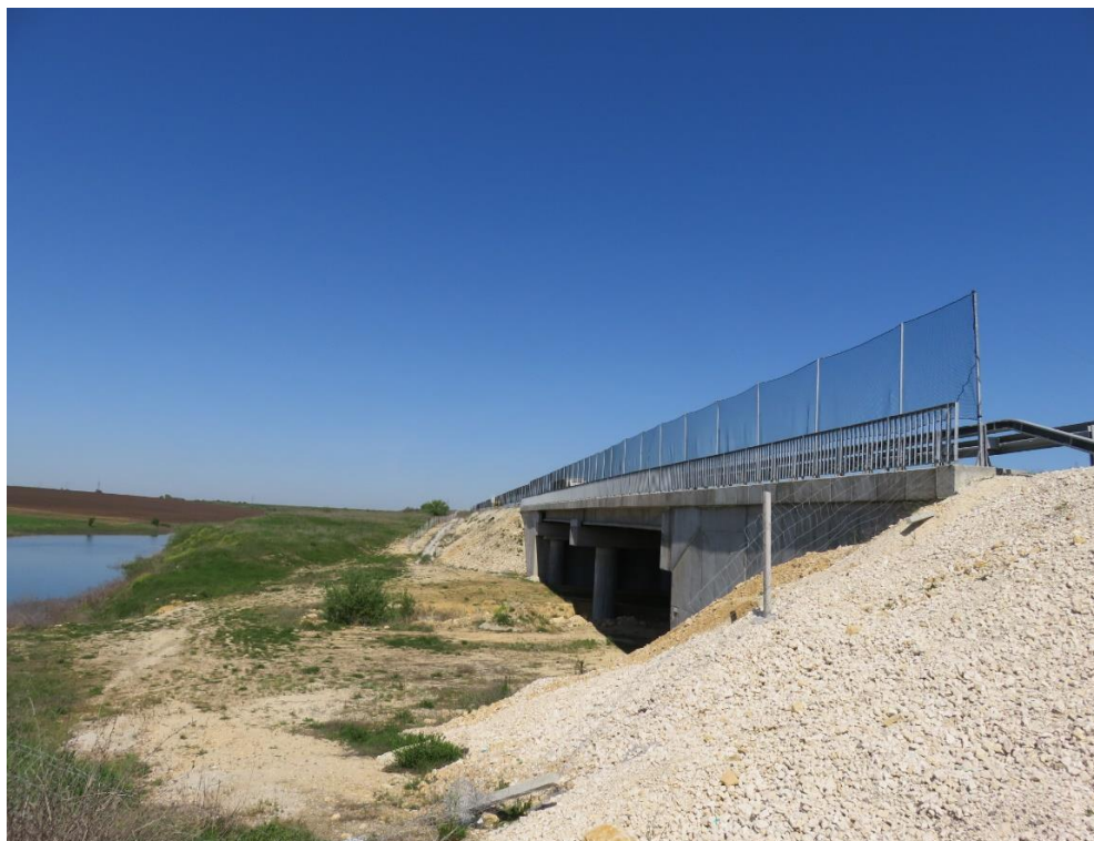
Снимка 38 Фундаменти на мост
