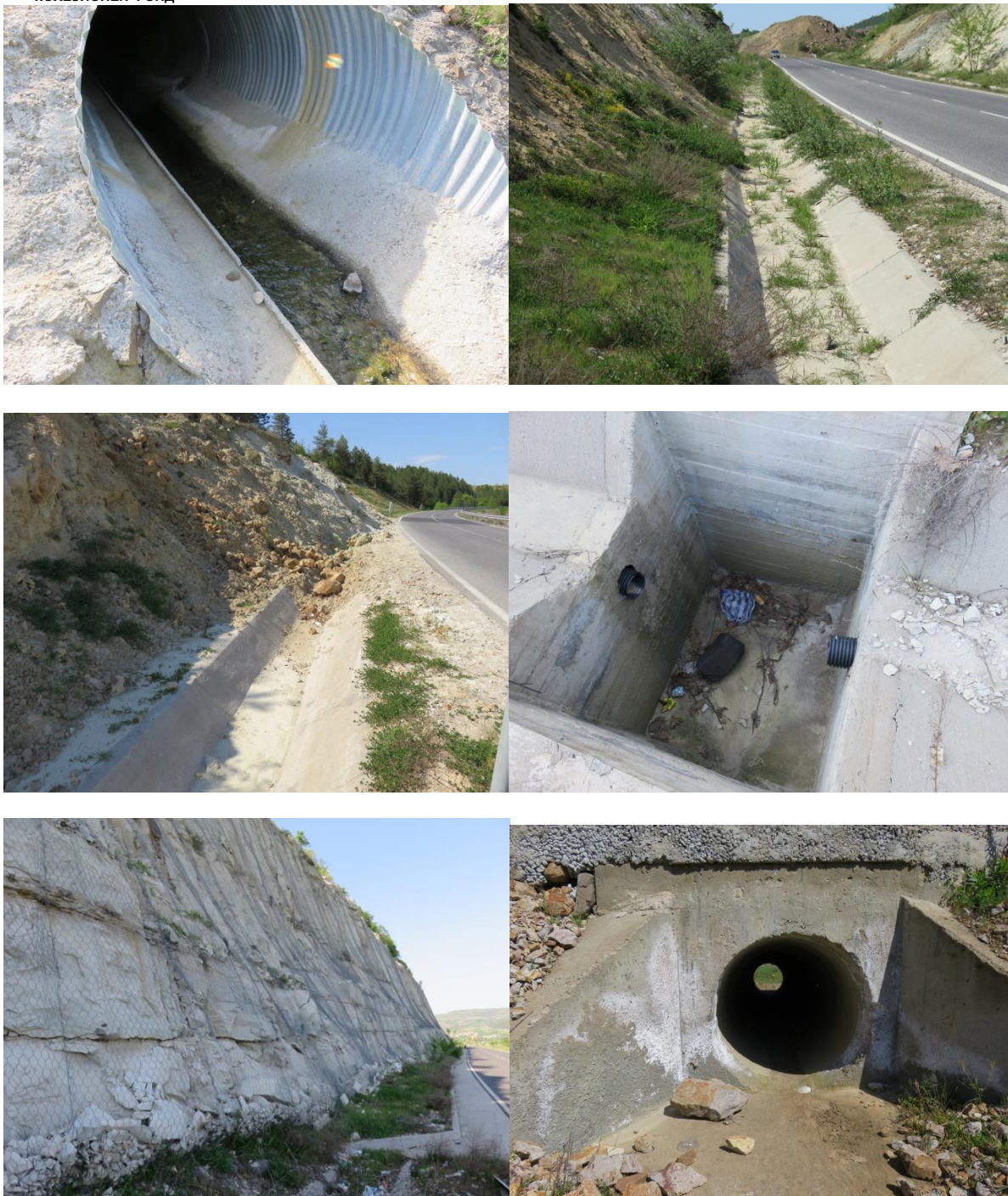
Снимка 7 Изследвани съоръжения при обхода на участък Кърджали-Подкова
