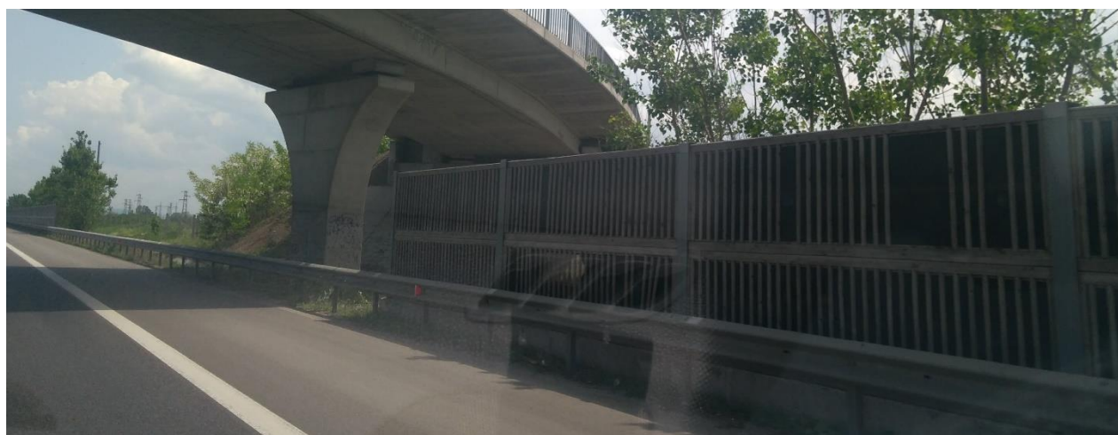
Снимка 59. Прекъсване на шумозащитния екран при пътя Г. Богров-Ботунец
