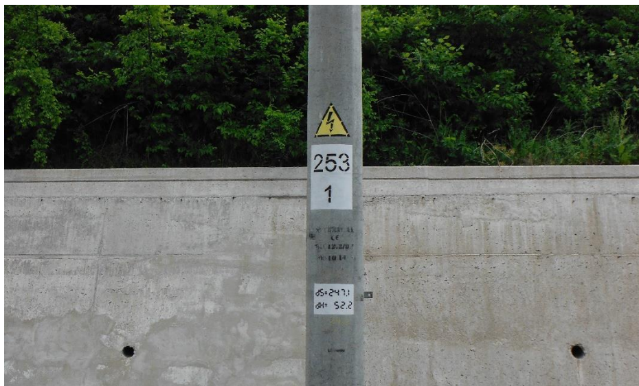
Снимка 31 Подпорна стена
