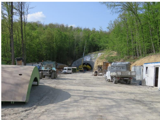
Снимка 48 Текуща работа по проекта
