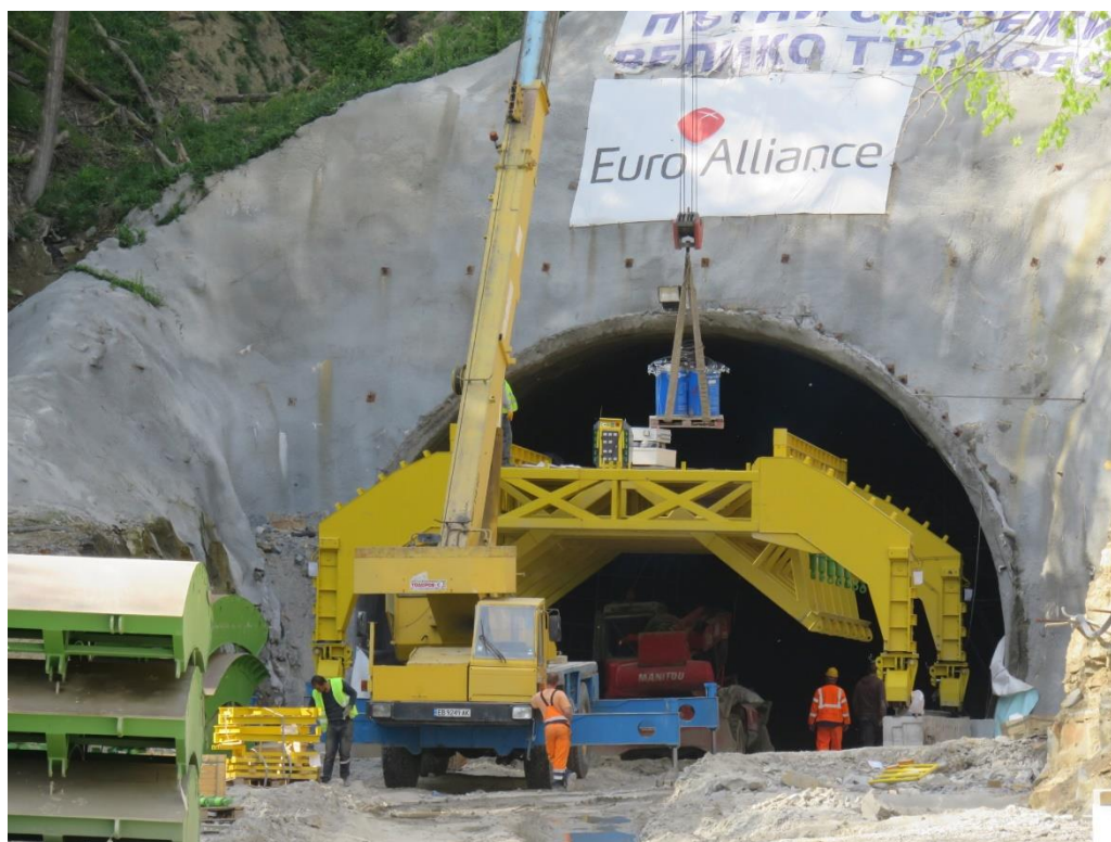
Снимка 26. Поглед към входа на тунела на км 12+420
