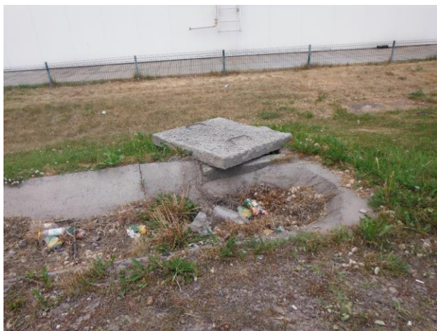
Снимка 10 Непочистени отводнителни канавки
