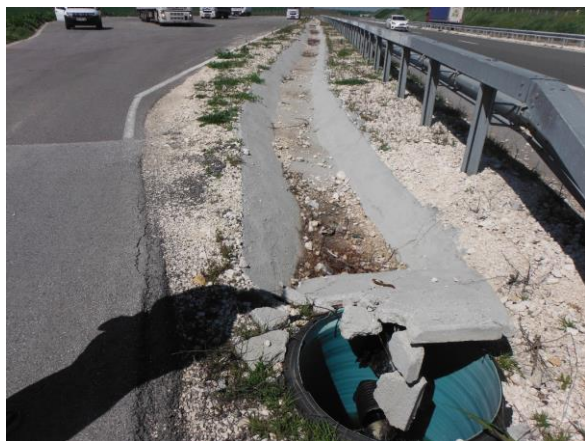
Снимка 9 Непочистена канавка и компрометиран капак на казанче
