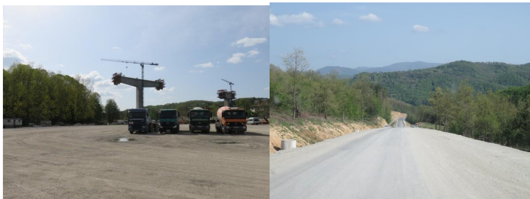
Снимка 4 Строителни дейности - обход на град Габрово
