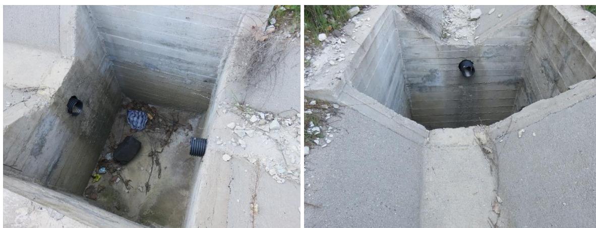
Снимка 45 Казанчетата и приемните шахти на канавките не са обезопасени
