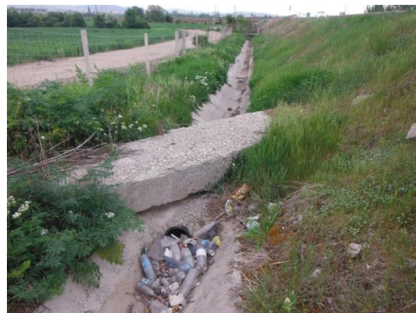
Снимка 11. Непочистени отводнителни канавки
