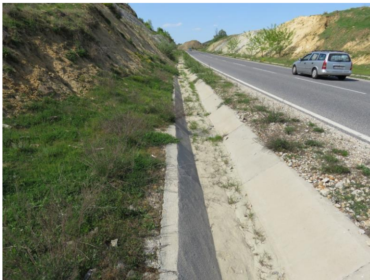
Снимка 12. Запълнена отводнителна канавки
