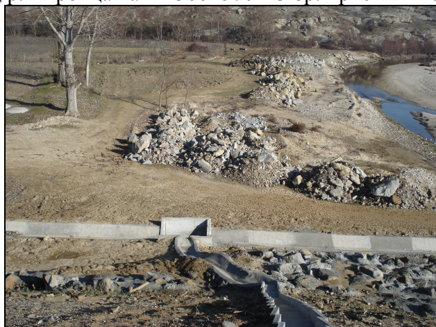
Сн. 19 Приемна шахта
