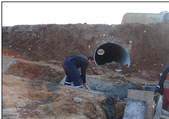
Сн.7. Проход при км 61+800
