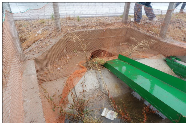
Сн. 9 Некачествено изпълнен проход за костенурки, който е закрит с мрежата за ограничаване движението на дребни животни
