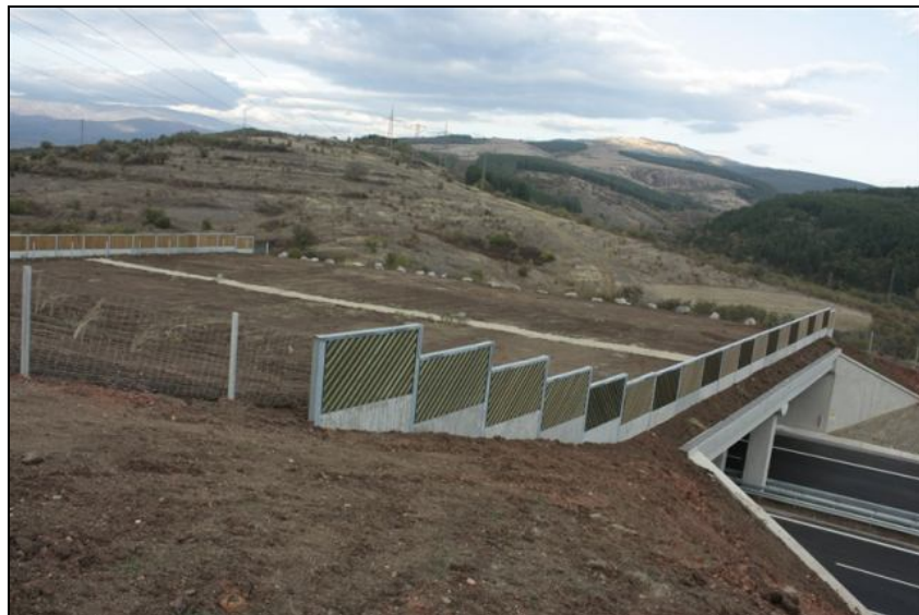
Сн. 5 Завършен вид на многовидовия надлез за опазване на мечка
