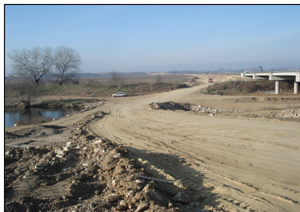
Сн. 11 Временен технологичен път през реката
