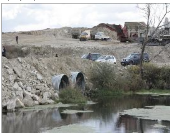
Сн. 10 Временно пропускане на водите
