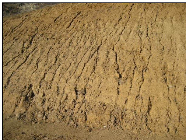
Сн. 16 и 17 Ерозионна дейност по откоси от свързани (песчливо-глинести) почви
