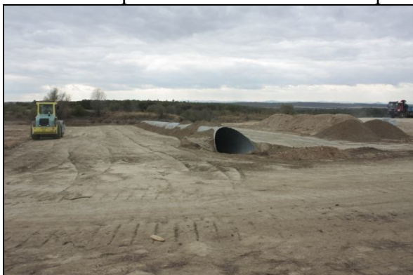
Сн. 8. Начален етап от полагане на водосток, който ще бъде използван и като биокоридор за дивите животни
