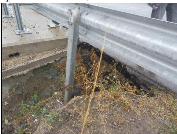
Сн. 5 Дълбока ровина при моста на р. Азмак
