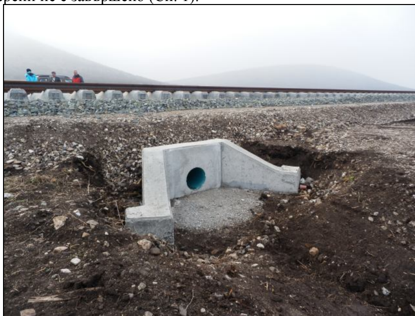
Сн. 1. Проход от полипропиленова тръба с диаметър 300 мм на км 152+760
