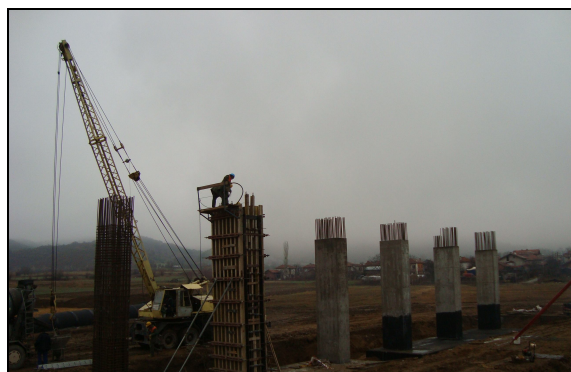
Сн. 12. Мост над р. Усойка
