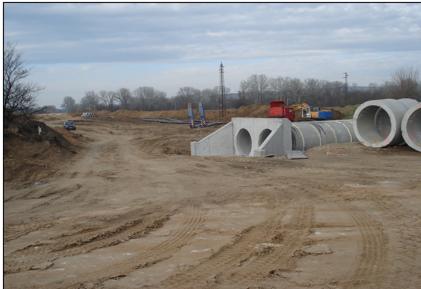
Сн. 14 Полагане на водостоци на участък 4 от фаза 4.2
