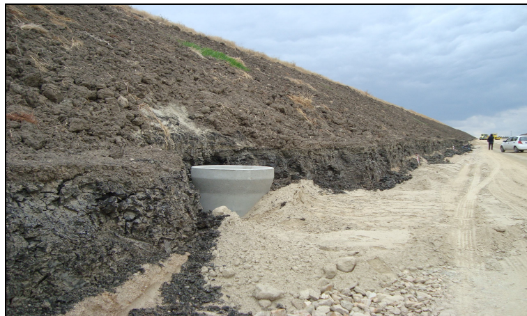
Сн. 23 Неоформени откоси и с начална фаза на ерозия
