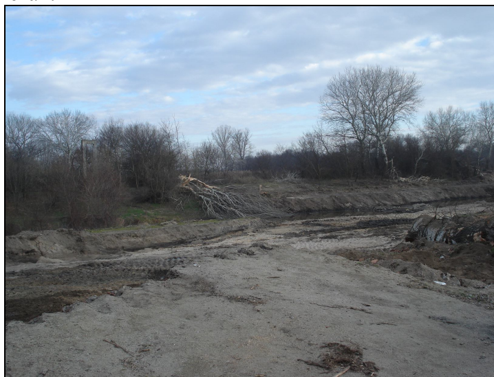
Сн. 13. Строителство още в начален етап при км 271+500
