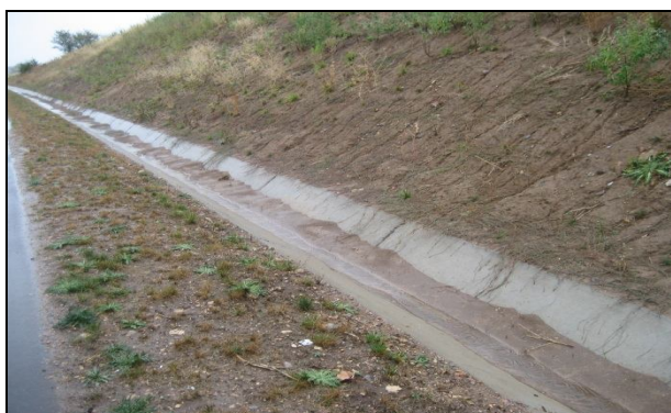
Сн. 18. Канавка с добро оттичане на водите,
