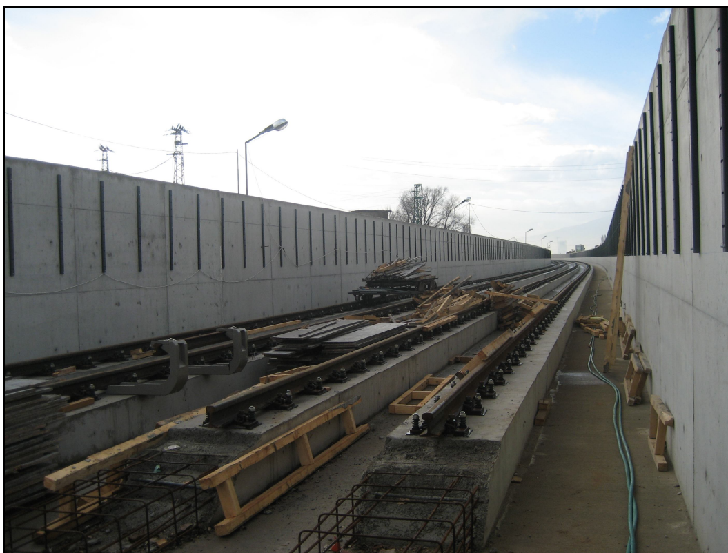
Сн.3 Бетонова част (височина 3.20 м) на шумозащитните екрани от „тунелен тип”
