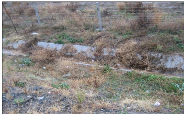
Сн. 19. Канавка запълнена растителност запълваща се от скатов материал
