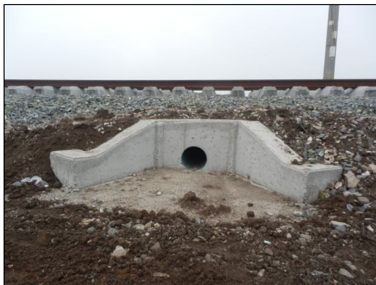
Сн. 2. Изграден проход за дребни животни при км 157+867
