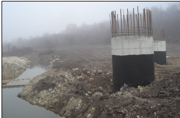
Сн. 3. Временна корекция на р. Стара река
