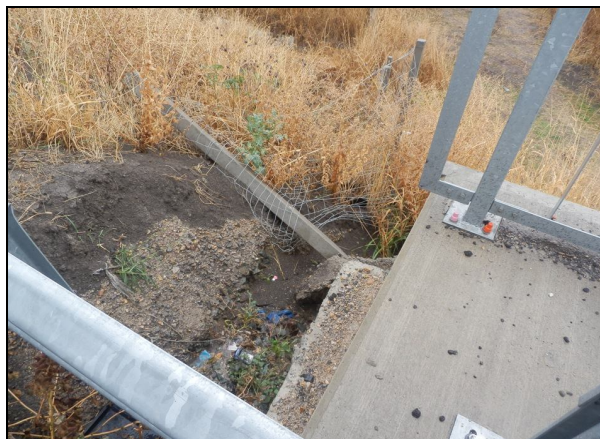
Сн. 6 Подкопан кол от оградата при моста на р. Азмак
