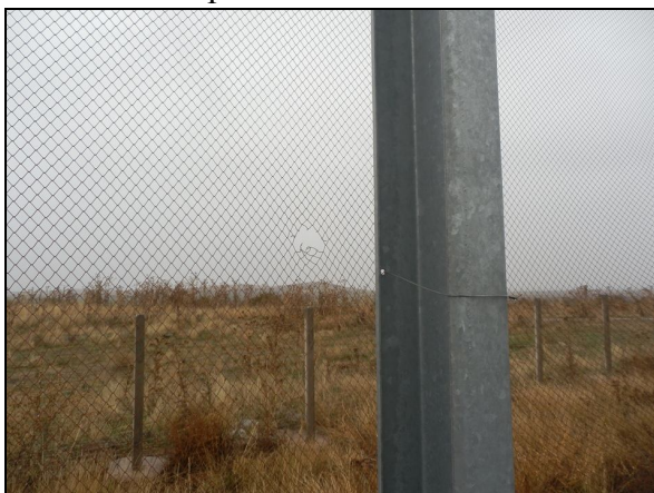
Сн. 10. Разкъсана мрежа в местата на захващане
