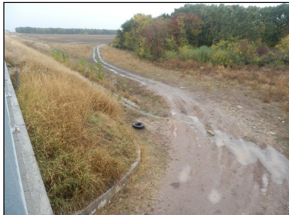
Сн.11 Канавката зауства в селскостопански път
