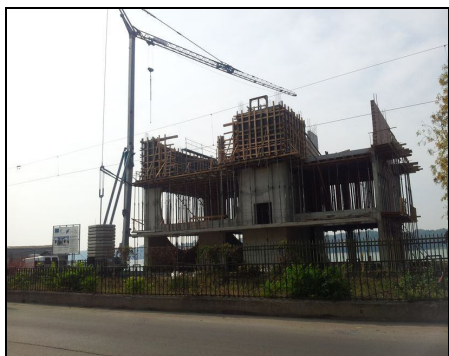
Сн.1 Сграда на РИС Център Русе в строеж
