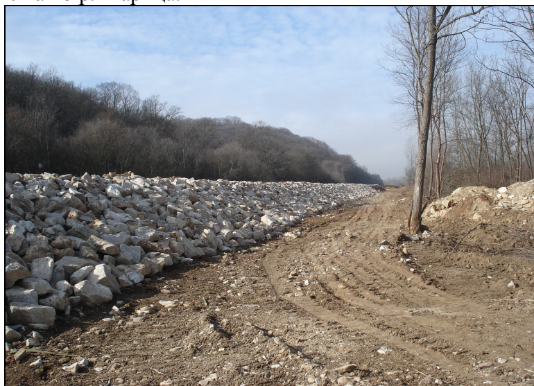
Сн. 5. Заскаляване на насипа за предпазване от 100-годишна вълна по р. Марица
