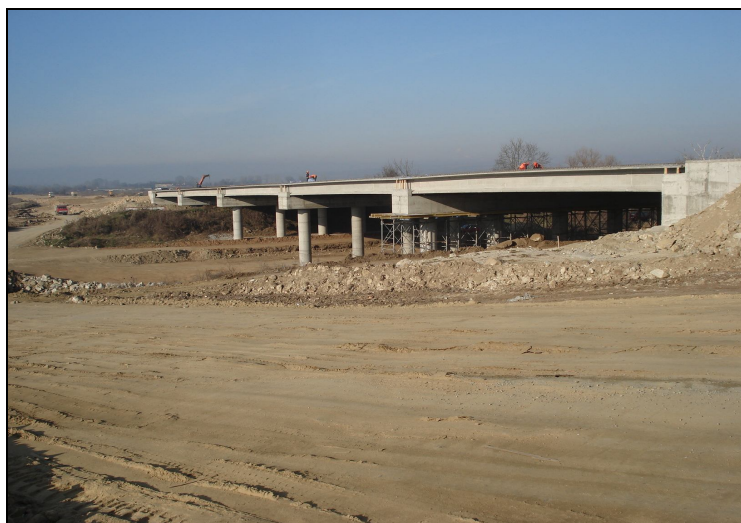
Сн. 12. Новоизграден мост над р. Харманлийска
