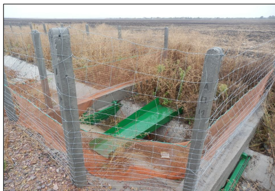
Сн .8 Буренясал проход за костенурки
