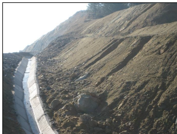
Сн. 16 и 17 Ерозионна дейност по откоси от свързани (песчливо-глинести) почви
