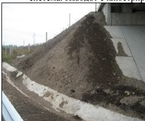
Сн.14. Запълване на канавка от нестабилизиран откос
