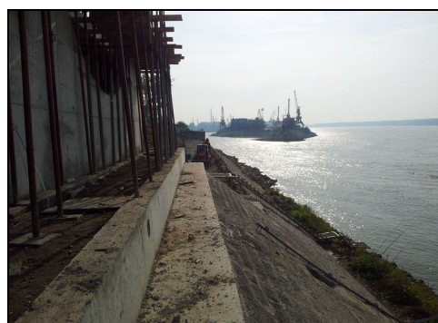
Сн.2 Кейова стена до сграда на РИС Център Русе в строеж.
