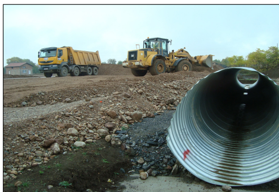
Сн. 1 По целият участък се работи
