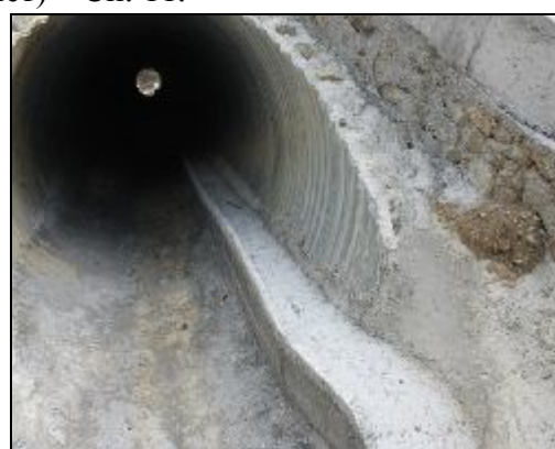
Сн. 11. Изградена бетонова пътечка с парапет за преминаване на дребни животни през водосток
