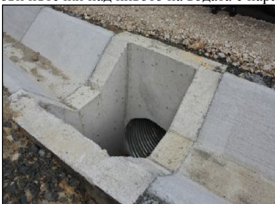
Сн. 10. Водосток с изградено казанче, който не може да бъде използван като прелезно съоръжение за дребни животни
