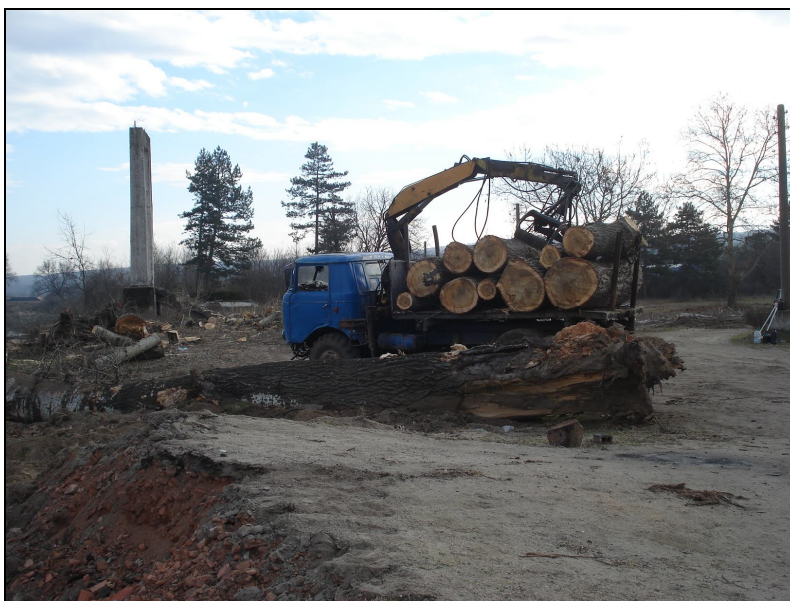
Сн. 16. Изсечена крайречна дървесна растителност
