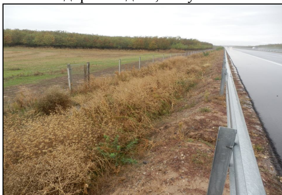
Сн. 2 Обраснали с трева канавки
